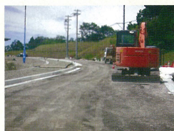
公共道路路盤(田辺市)
