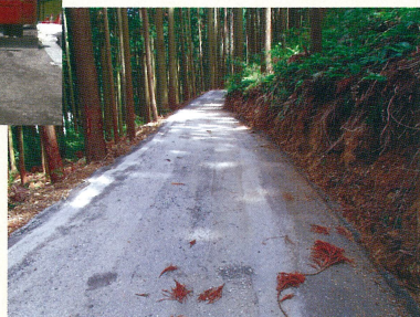
林道舗装(有田川町)
