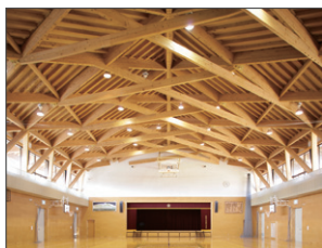
橋本市立高野口小学校 体育館 (橋本市高野口町)
