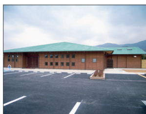
橋本市地域活性化交流施設 (橋本市)
