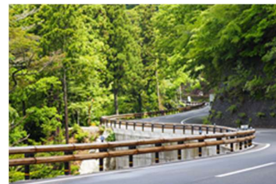
木製ガードレール
