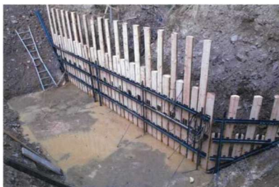
木製残存型枠
