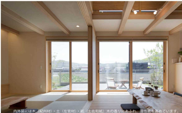
内外表には木（紀州材）・土（左官材）・紙（土佐和紙）木の香りにあふれ、湿性を高めています。
