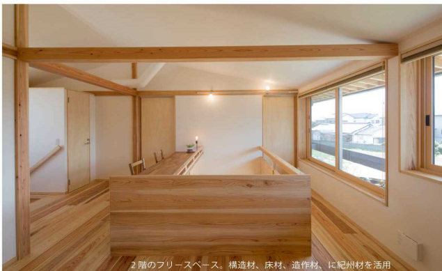
2階のフリースペース。構造材、床材、造作材、に紀州材を活用
