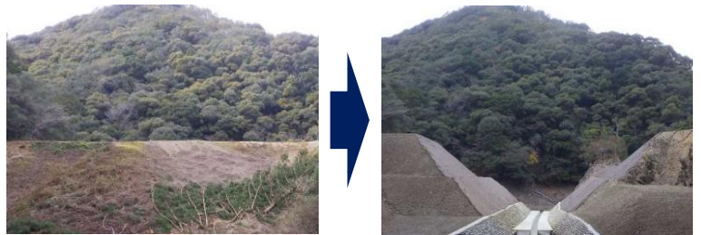
堤体をV字形にカットし、貯水できないようにする廃止工法
