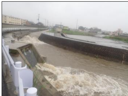
令和6年度供用開始した七瀬排水路放流工 （和歌山市） 令和6年5月放流状況
