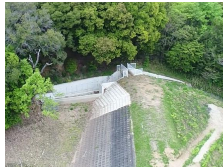
《部分改修》 (洪水吐・緊急放流施設整備)
