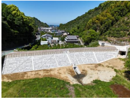
《全面改修》 (堤体・洪水吐・取水施設等整備)
