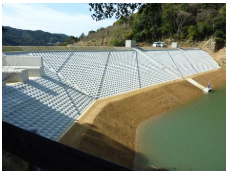
老朽化したため池の改修
