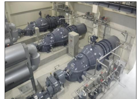
令和6年度供用開始した名草排水機場 （和歌山市）
