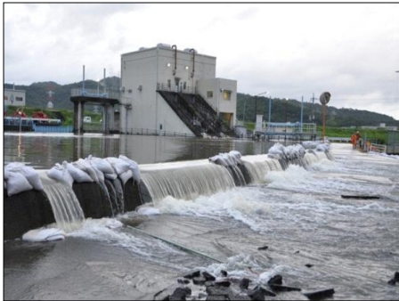
H23.9.1～4 台風12号 排水機での排水が追いつかず、 道路へ越水した排水路（紀の川市）
