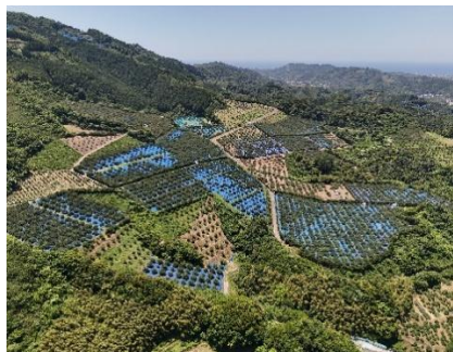
緩傾斜化による樹園地の区画整理
