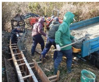
長寿命化活動 （水路の補修）
