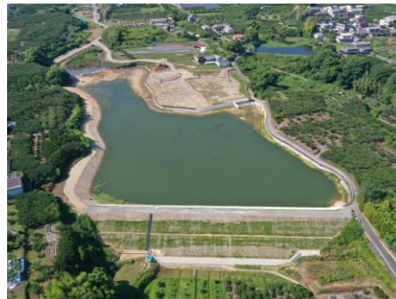
令和6年度完成の大溜池 （紀の川市）
