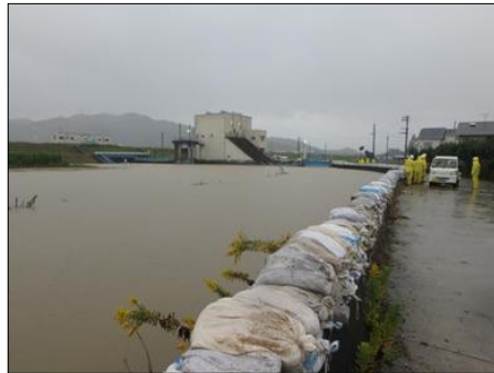
H29.10.20～23 台風21号 排水機での排水が追いつかず、土のう により道路への越水を辛うじて防いで いる（紀の川市）
