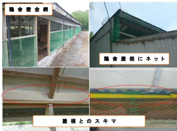
図5:鶏舎修繕(上A, C, D舎)
