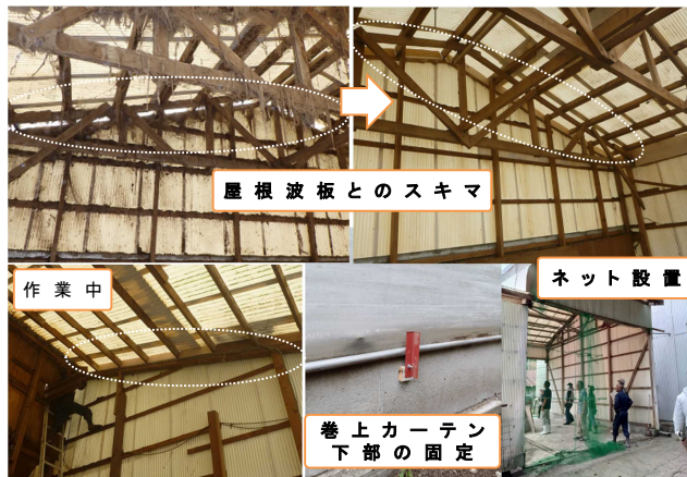
図6:鶏糞攪拌施設修繕
