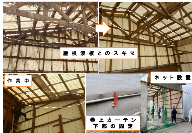
図6:鶏糞攪拌施設修繕
