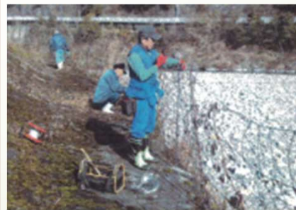
・ 獣害柵の点検、補修
