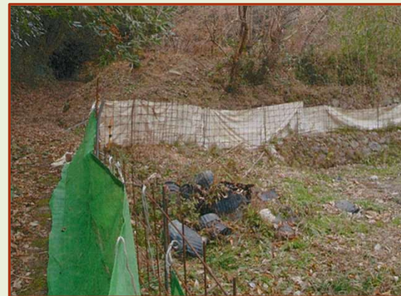
○獣害防止柵の設置状況
