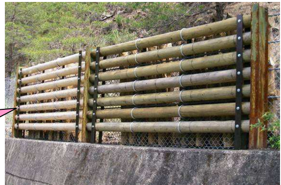
写真1 紀州材を使った落石防護柵
