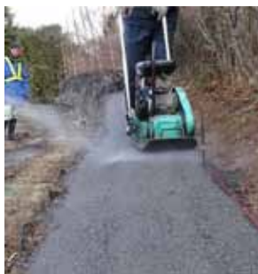
散水と転圧による施工
