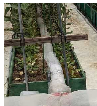
写真1 局所加温ダクト設置状況
