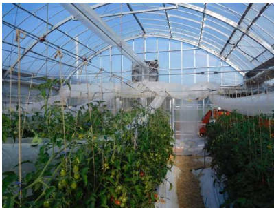
図 1 ミニトマトの成長点付近への加温用ダクトの設置状況
