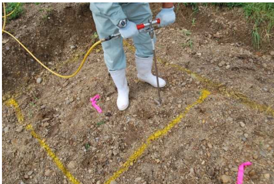
写真11 かん注による処理
