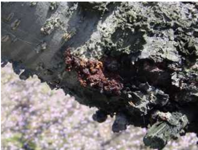
主幹部の被害
