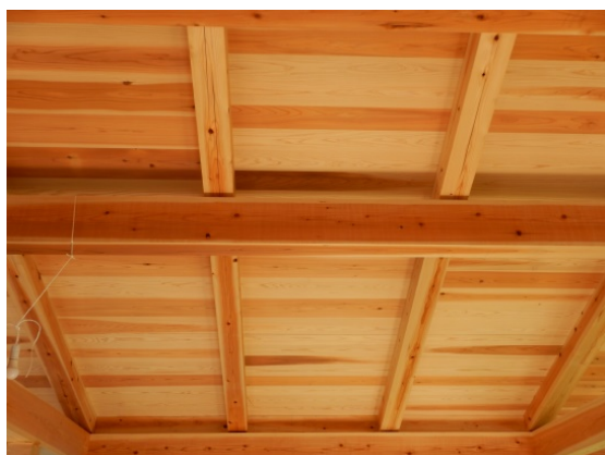
図1 スギ床パネルの実際の施工写真
