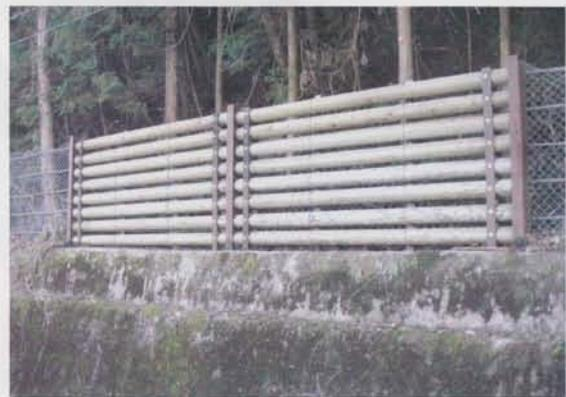
写真2 試験設置した木製落石防護柵
