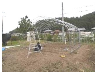
アーチパイプの設置
