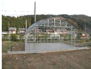
土間コンクリートの打設
