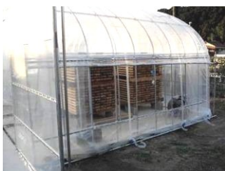
シート巻き上げ時
