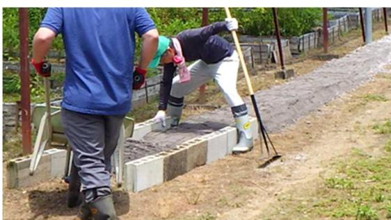
その後、十分に散水しながら、平坦で広い部分はプレートコンパクターをかけ、傾斜部分や狭い部分は土を均すトンボで叩くと施工完了となり、約2週間で硬化します。今回、1m幅で施工したことが影響したのか、散水して柔らかくなった部分ではプレートコンパクターが沈み込んでスラグが飛び散り陥没してしまいました。対策として、徐々に締め固めるよう、散水前、散水途中と複数回プレートコンパクターをかけました。それでも沈み込む場合は、プレートコンパクターにロープを結んで前方から引っ張り上げながらかけると綺麗に施工できました。
