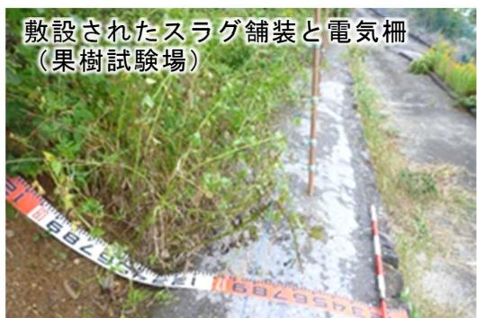
今回、林業試験場中辺路試験地の第1苗畑に鉄鋼スラグ（日本製鉄「カタマ®」）舗装を実証的に敷設しました。トラックにより運ばれてきた鉄鋼スラグを一輪車で運び、約1m幅で敷き詰めています。そのまま鉄鋼スラグを敷いていくより、コンクリートブロックを1m幅で並べておき、そこに敷く方が、簡単かつきれいに敷き詰めることができました。
