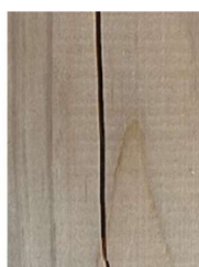
写真B (幅 1 mm 程度の割れ)
