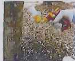
(写真8 薬剤の注入)
