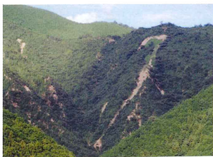
山が急峻な所は崩壊の危険がある
