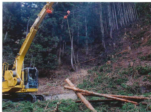
写真2 スイングヤーダによる集材作業
