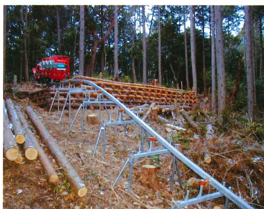
(モノレールと作業土場の状況)
