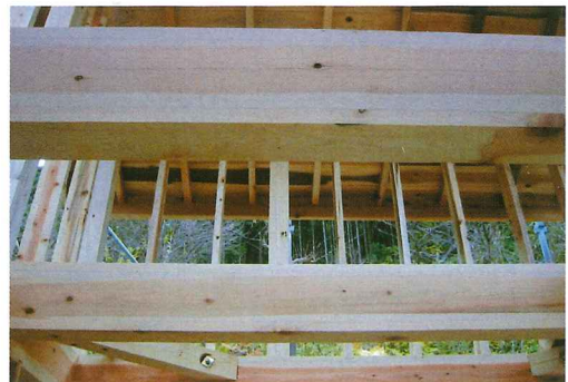
写真3 横架材として施工されている構造用複合積層材
