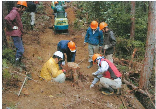
(小型バックホウと人力にて作業道作設中) 作業道作設技術 (11/8～12)
