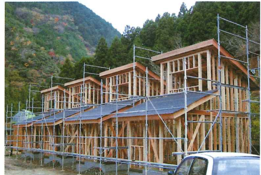
写真2 大塔青少年旅行村バンガロー(建設中)
