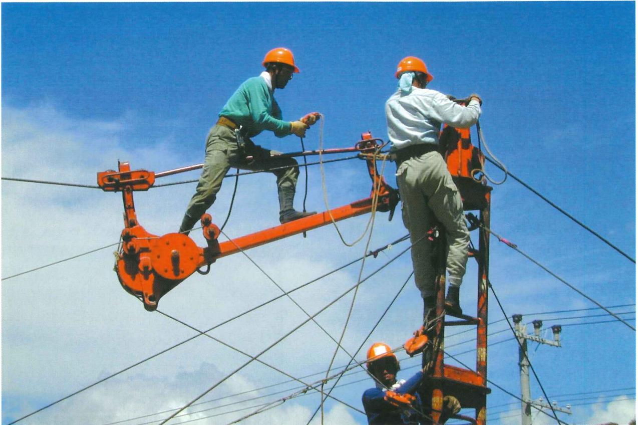
—ダブルエンドレス式架線架設作業(林業架線作業主任者講習)—
