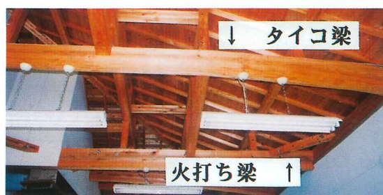
写真4 当センター木材加工研究棟の小屋組 すべてスギ材使用。タイコ梁、火打ち梁が見られる。
