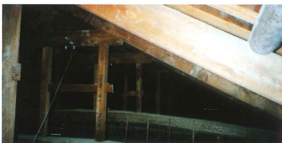
写真2 明治末期建設の校舎小屋組(和小屋) 今では珍しいツガやマツの曲がり材が使用されていた。
