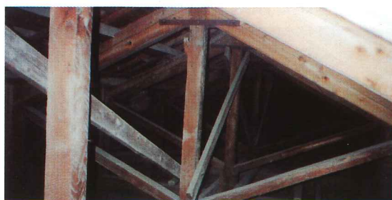
写真3 昭和初期建設の校舎小屋組(洋小屋) 使われていた木材はスギ、ヒノキ。
