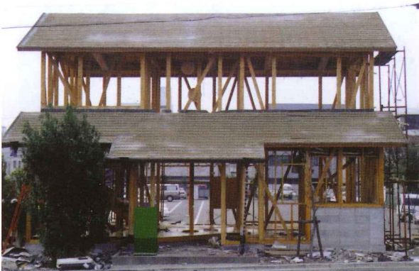
写真 調査対象とした木造モデル住宅（解体時）
