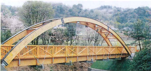
写真－1 にじのはし（県植物公園緑花センター） 橋長27m 有効幅員1.5m 総重量約22.4t
