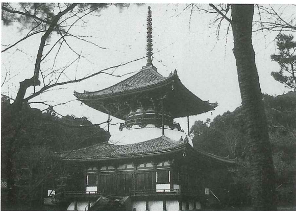
写真1 県内の伝統的木質構造の1例 根来寺 多宝塔（1496年建立） 高さ40m、横幅15m
