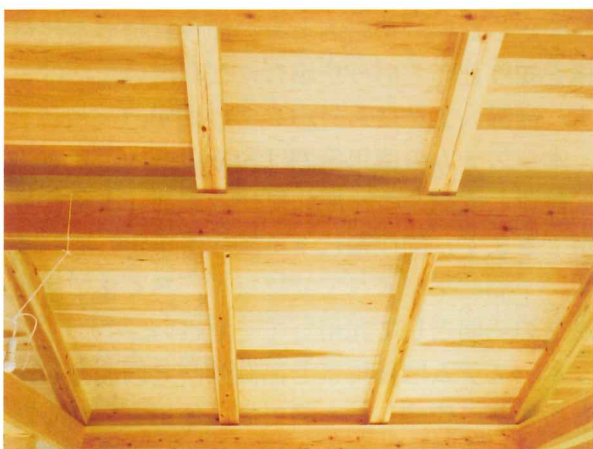
図1 スギ床パネルの実際の施工写真
