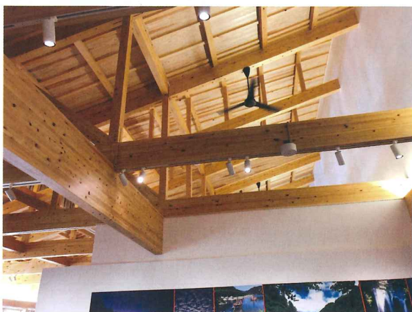
【1階展示室から見た小屋組み現し】
