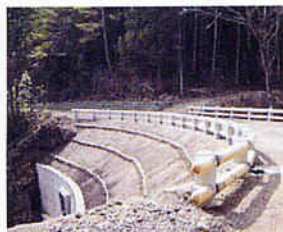
写真2 木製ガードレール
