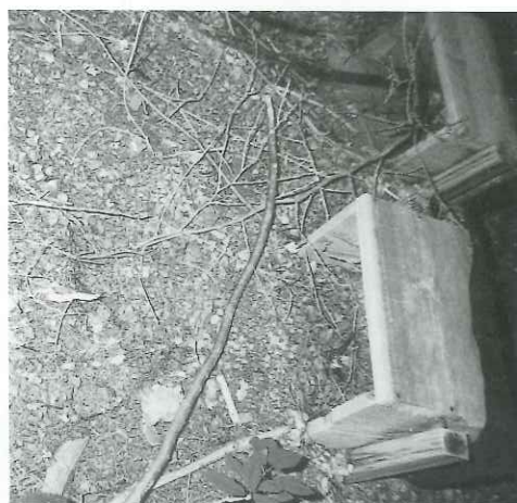
写真2 土砂受け箱にたまった土砂
