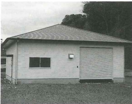
竣工間近の木材加工研究棟
