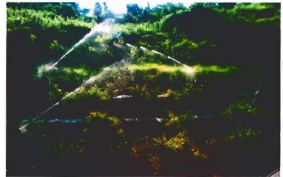
写真1 自在型スプリンクラーの散布状況
