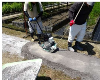
図6 転圧(プレートコンパクター)
