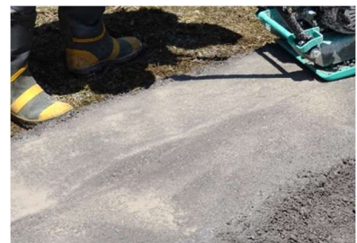
図7 転圧終了(泥水が浮きます)
