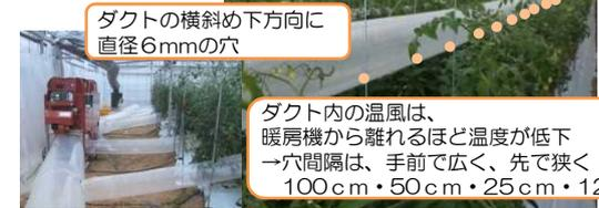
ダクトの横斜め下方向に直径6mmの穴
