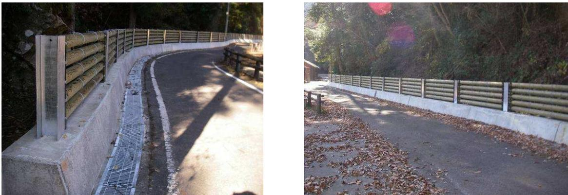
図 8 木製落石防護柵の実用化事例（田辺市龍神村）
