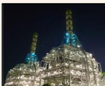
▲川崎天然ガス発電所
