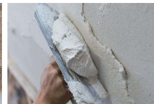
しっくい施工
