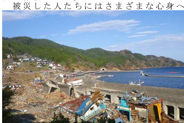
(津波で破壊された堤防【釜石市唐丹地区】)
