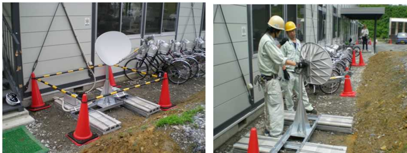
仮設住宅への衛星設備設置の様子(正光電気工業株式会社施工)
