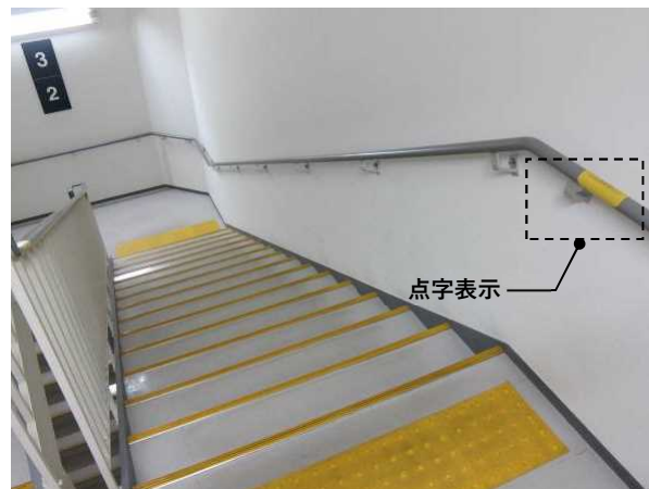
・階段手すりに設けられた点字表示
