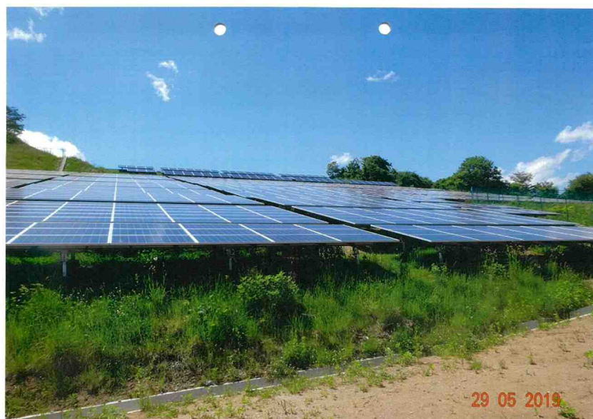
図表 2-8 太陽光発電所種子吹付例（宮城県栗原市）
