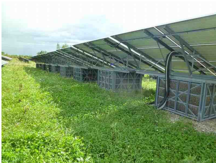
図表 2-6 太陽光発電所種子吹付例
