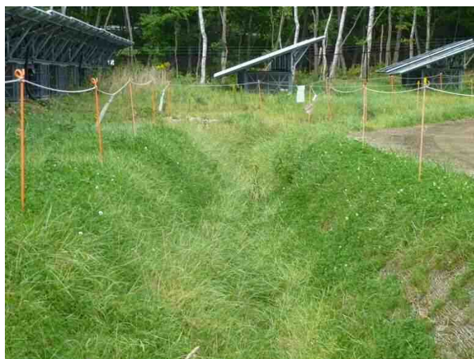
図表 2-7 太陽光発電所種子吹付例
