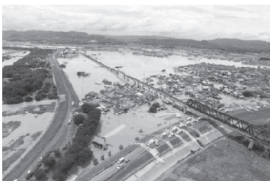
左：「平成30年7月豪雨」による被害状況（岡山県倉敷市真備町）資料）国土交通省
