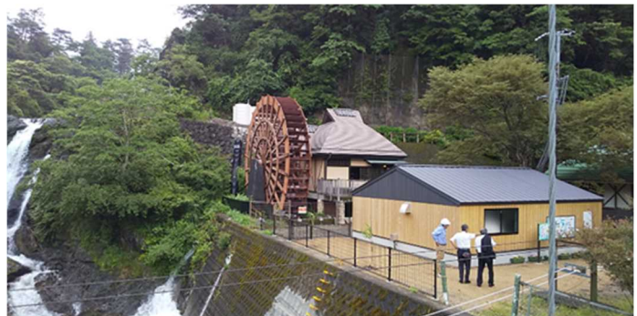
金剛の滝水力発電所
