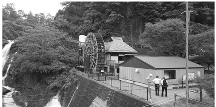
金剛の滝水力発電所
