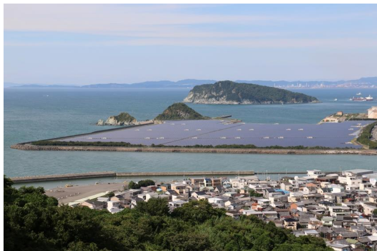
有田太陽光発電所
