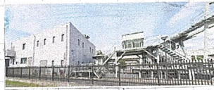
←雨水ポンプ所 和歌山市紀和駅前公園横
