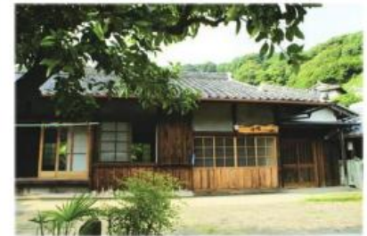
4-9 田舎生活体験施設 木市
