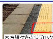
内方線付き点状ブロック
