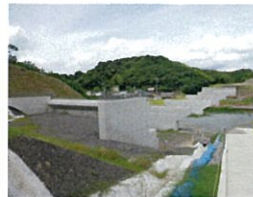
南紀田辺～すさみ間工事状況
