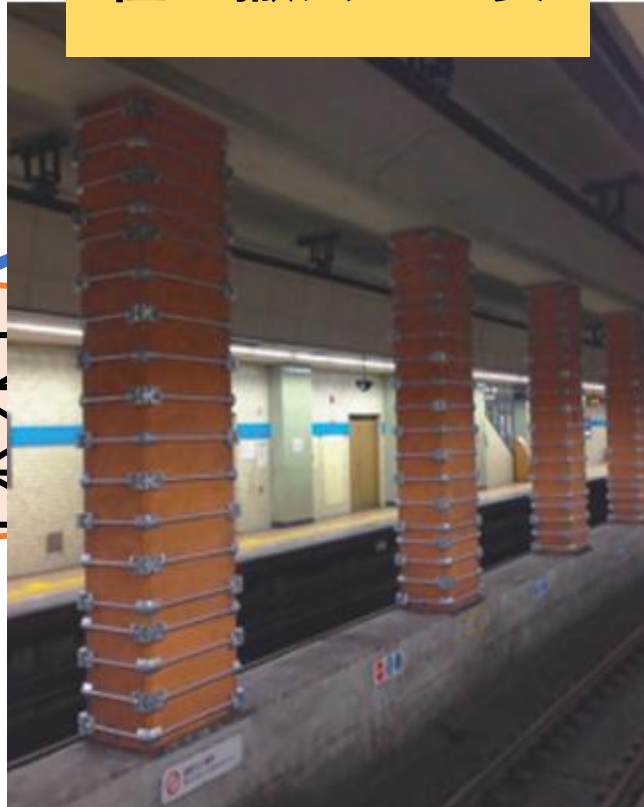
リブバー耐震補強工法
